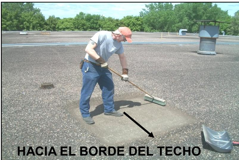
En los techos cubiertos con piedrecillas, BUR, gravilla, etc., barra toda la gravilla, la tierra y el polvo en la zona donde se colocará el anclaje. Deje por lo menos 3 pies de zona barrida delante del anclaje (en dirección al borde del techo).
